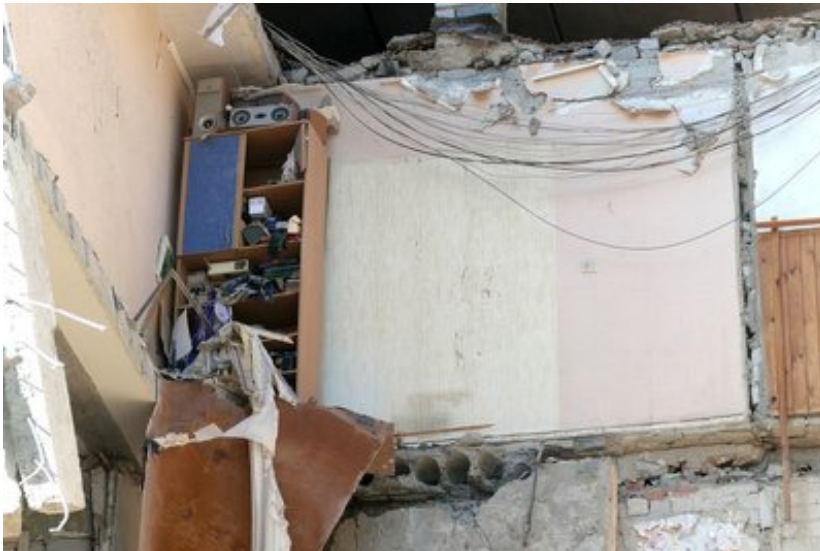
Пошкоджена багатоповерхівка у Свесі. Суспільне Суми
