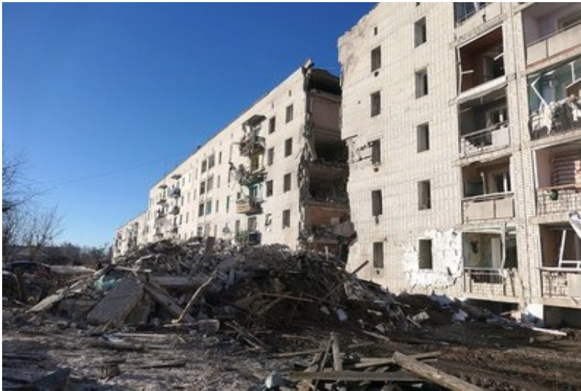
Пошкоджена багатоповерхівка у Свесі. Суспільне Суми
