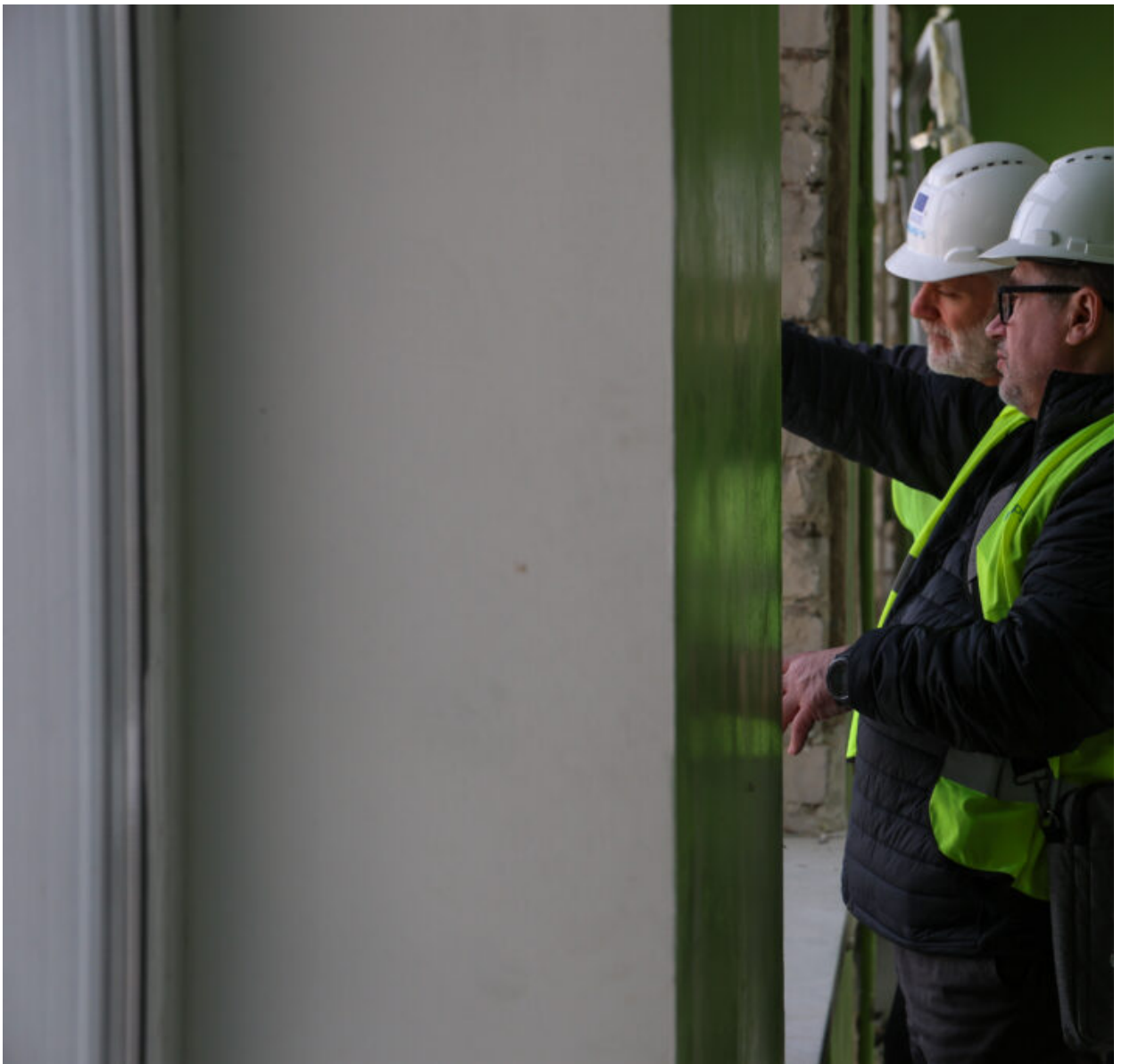
Ремонт в одній із шкіл проєкту. © Юрій Верес / ЮНОПС
