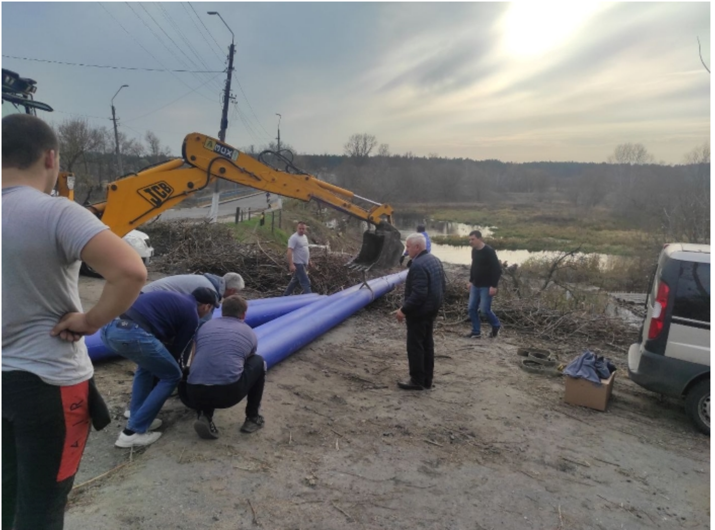
Реконструкція міського водогону. Кінець 2023 року
