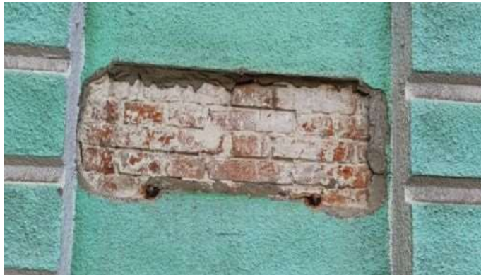
Фасад будинку на Гончарівському бульварі
