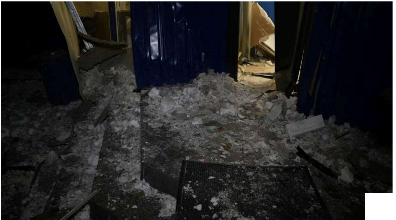
Наслідки обстрілу, Запоріжжя, 19 жовтня 2024 року. Суспільне Запоріжжя
