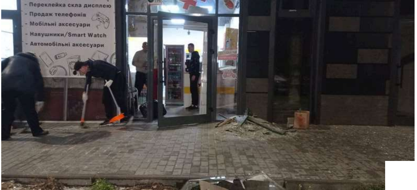
Наслідки обстрілу, Запоріжжя, 19 жовтня 2024 року. Суспільне Запоріжжя
