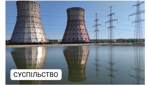
Терехов повідомив, коли ввімкнуть опалення в Харкові
