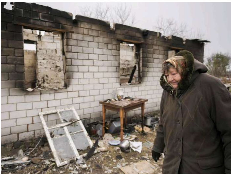
Жінка проходить повз зруйнований будинок в Андріївці, 5 квітня 2022 року, фото: AP Photo/Vadim Ghirda
