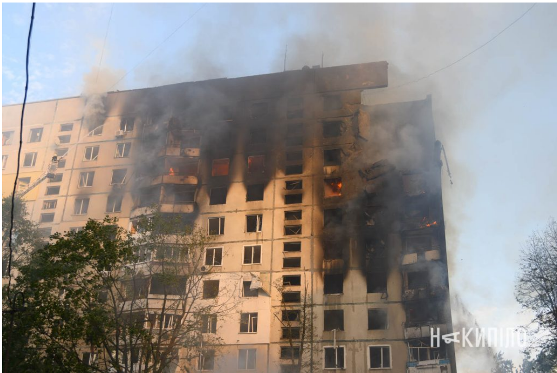
Обстріляна багатоповерхівка на вулиці Бібліка, 30 серпня 2024 року. Фото: Ігор Лептуга
