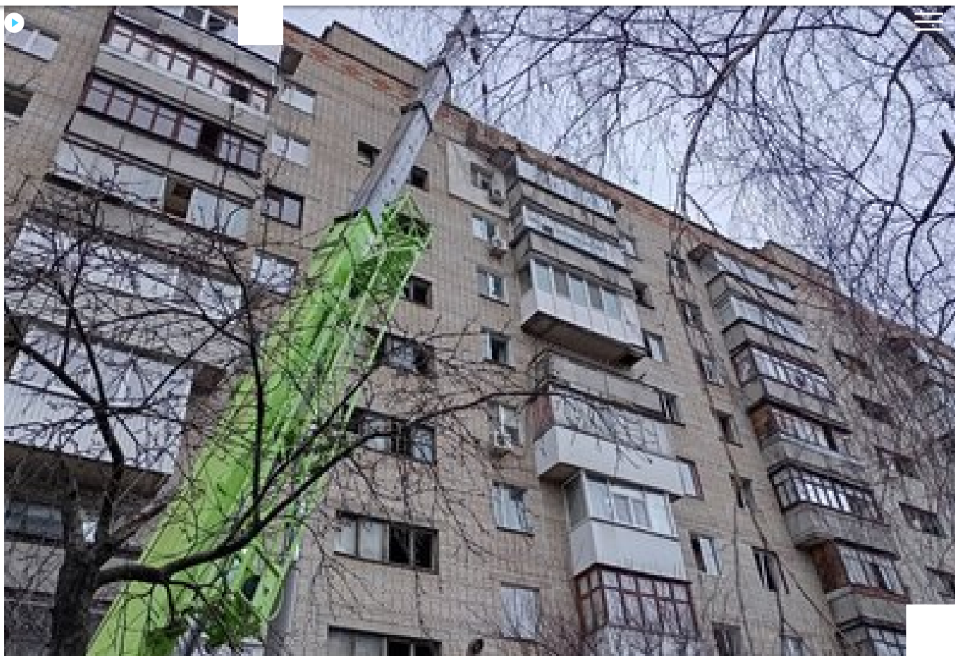
Демонтаж плити, Суми, 24 березня, 2025 р. Суспільне Суми
