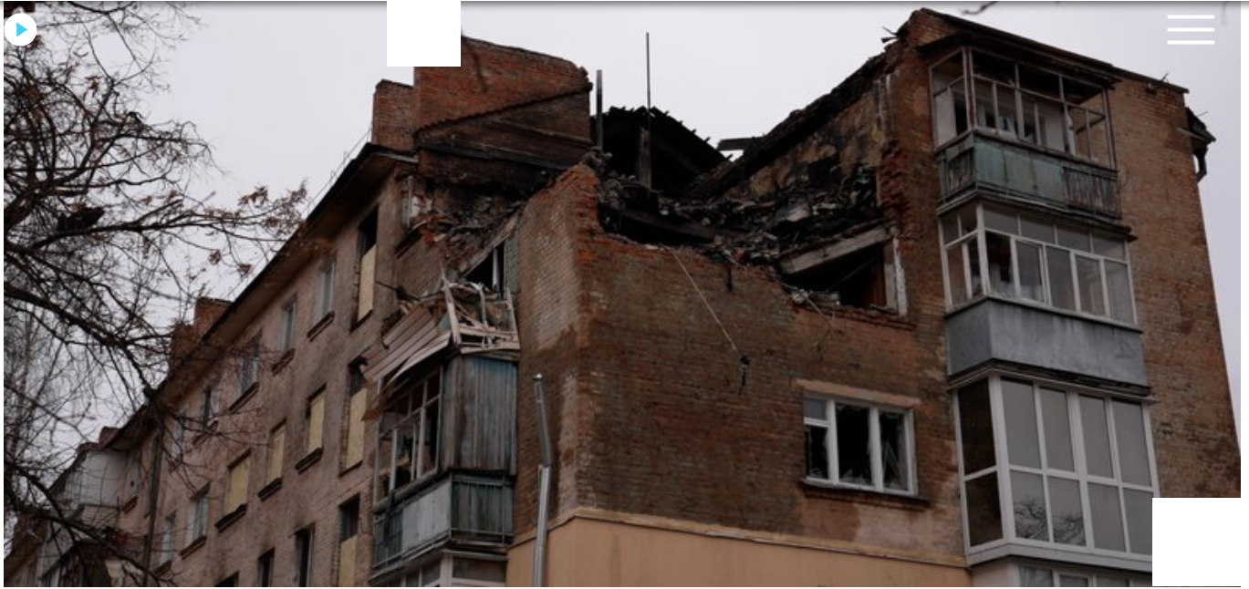
Зруйнований будинок Катерина Радченко. Суспільне Чернігів
