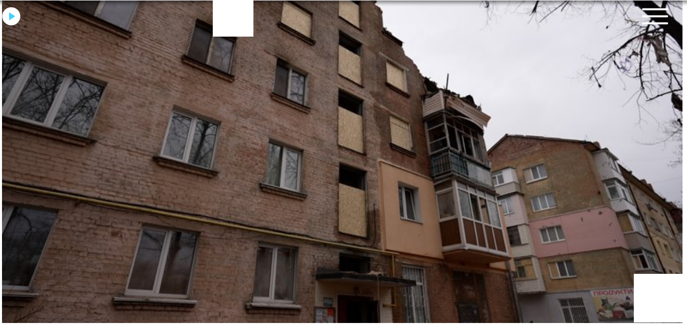
Зруйнований будинок Катерина Радченко. Суспільне Чернігів
