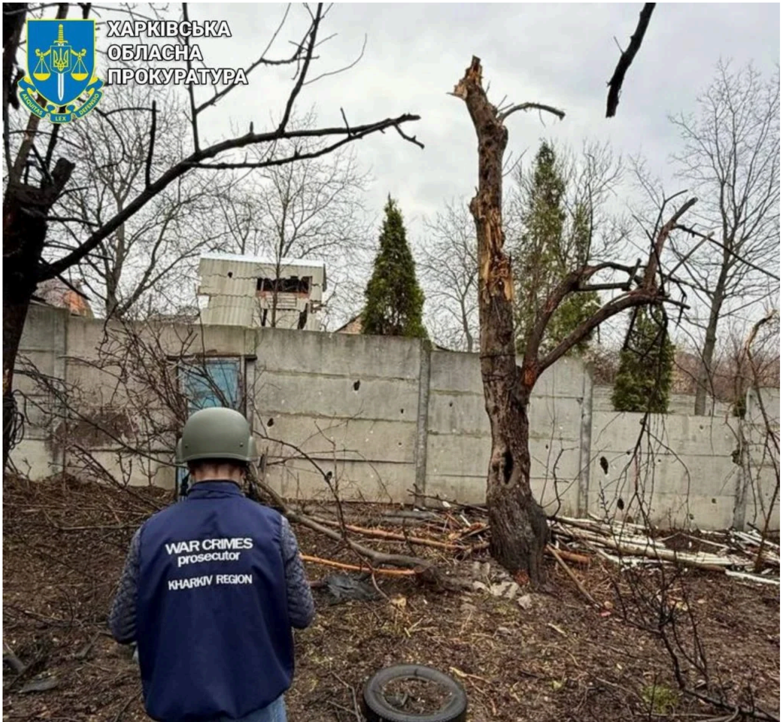
Місце влучання шахеду в Харкові. Фото: Облпрокуратура
