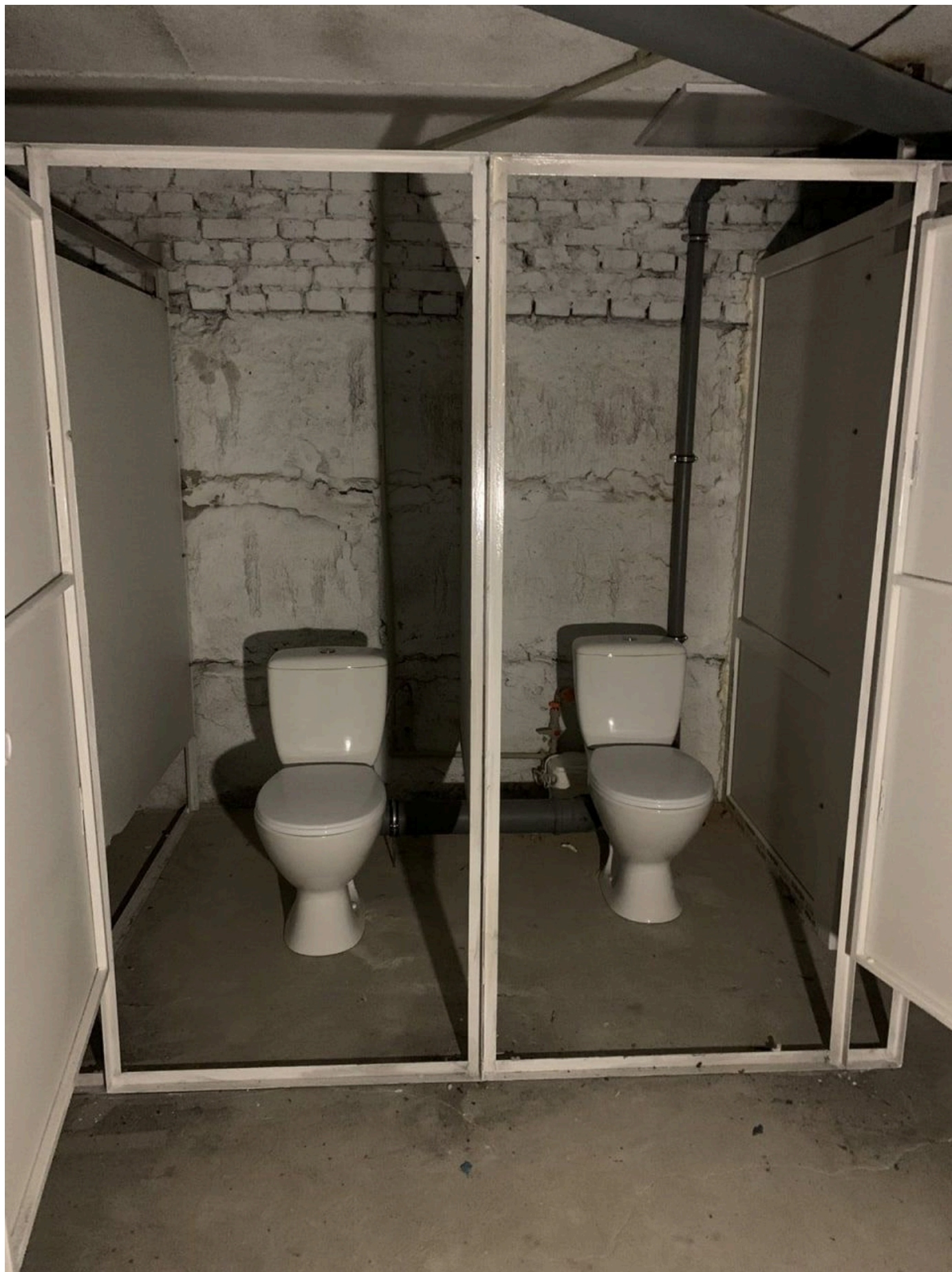
Поточний ремонт укриття у ЗОШ № 26 торік у грудні (фото Департаменту освіти Полтавської міськради)
