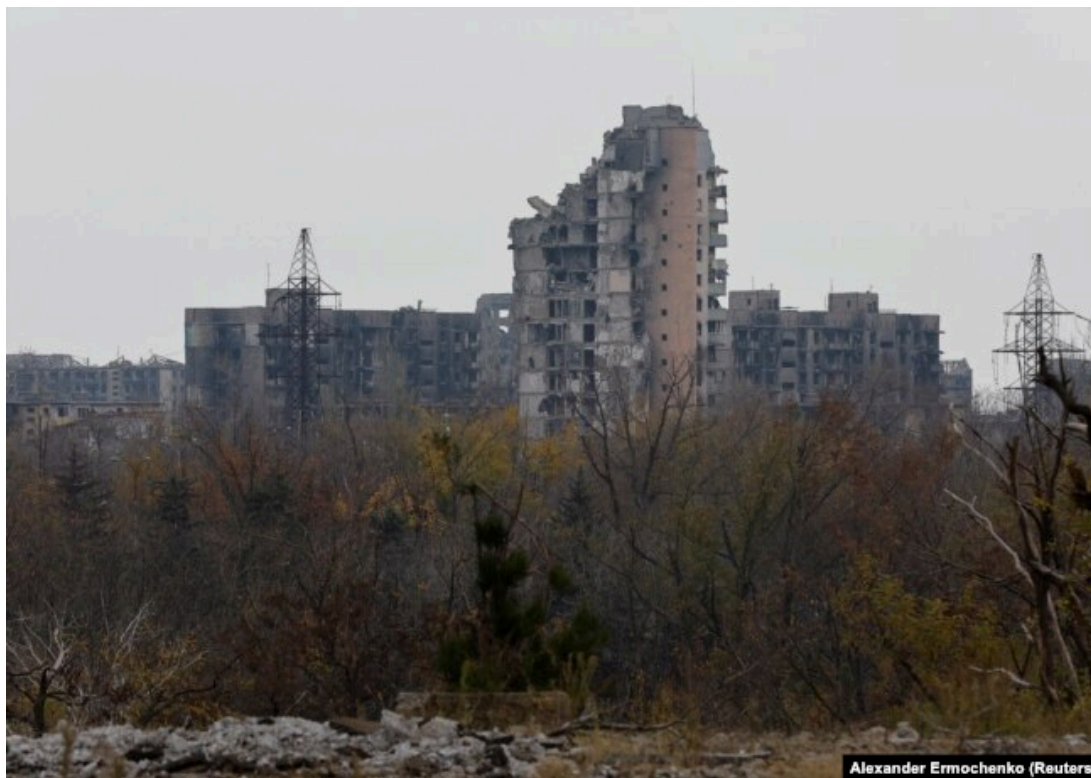
Вид на будівлі, пошкоджені російськими обстрілами в нині окупованому Маріуполі. Україна, 9 листопада 2022 року
