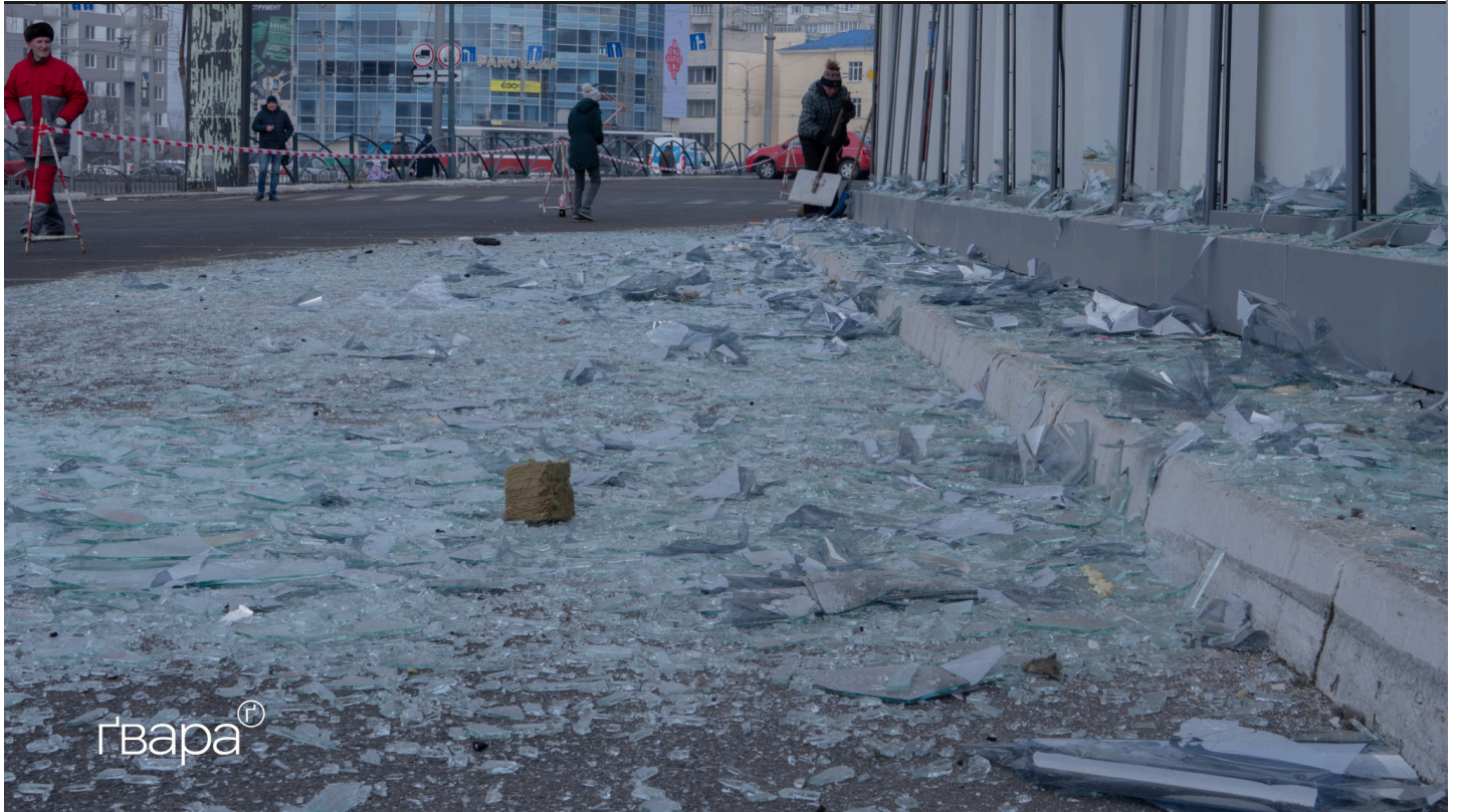
Пошкодження житлового комплексу в Шевченківському районі / Фото: Любов Ємець, Гвара Медіа
