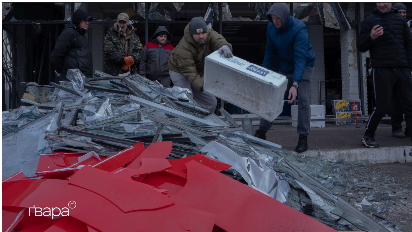
Пошкодження житлового комплексу в Шевченківському районі / Фото: Любов Ємець, Гвара Медіа
