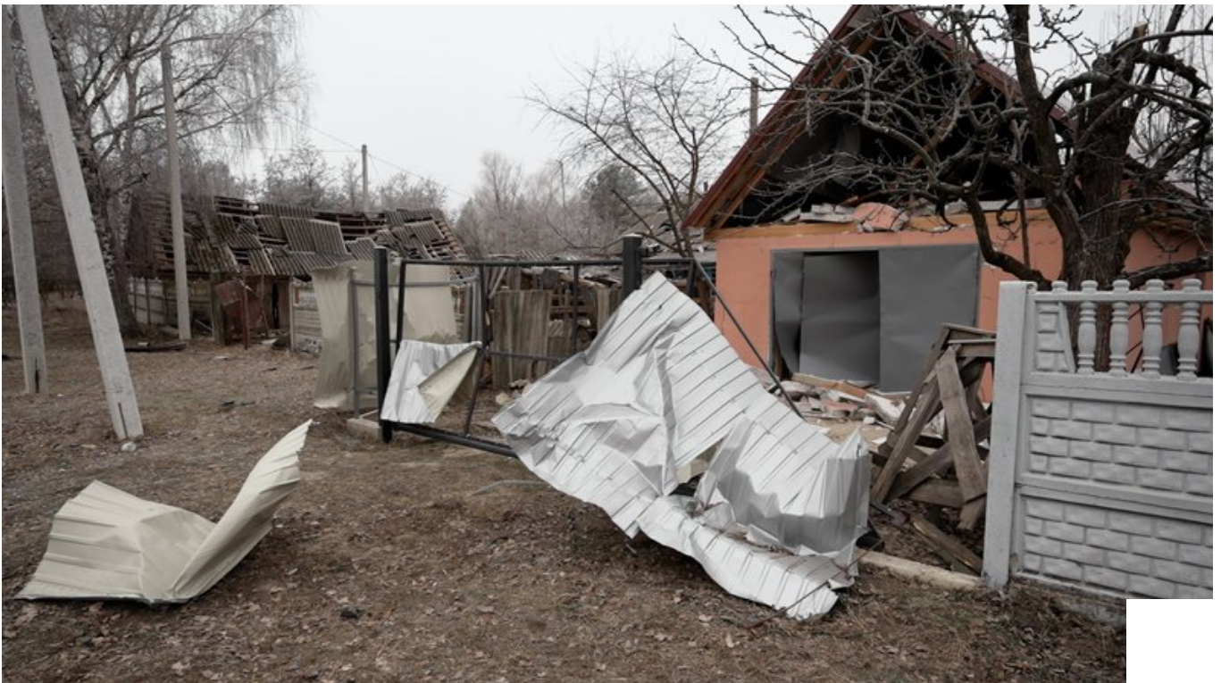
Пошкоджені будинки в Євминці. Суспільне Чернігів
