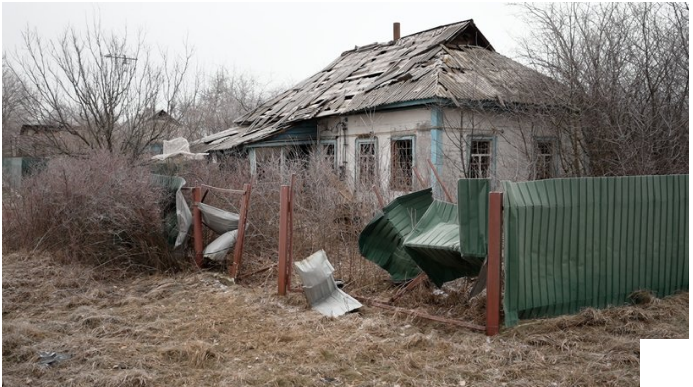
Пошкоджений будинок в Євминці. Суспільне Чернігів
