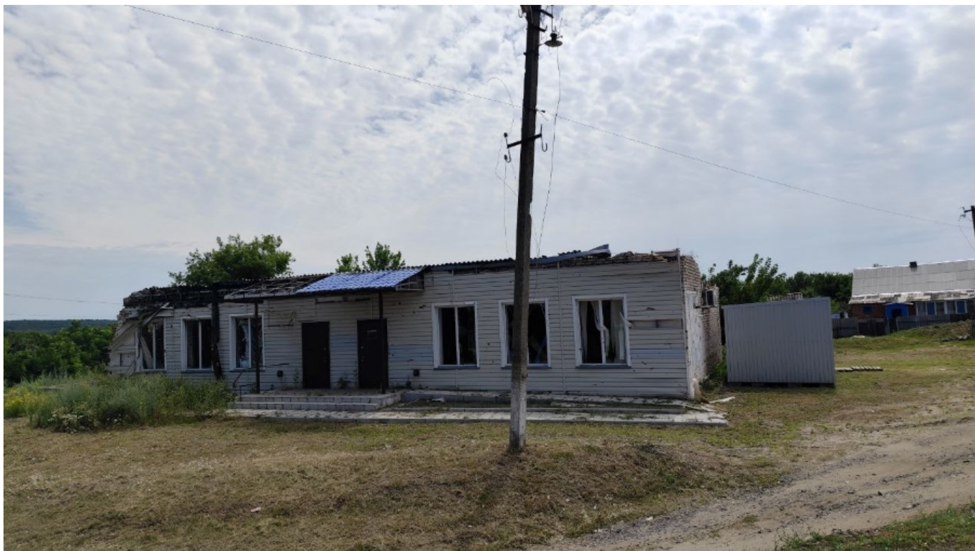
Зруйнований магазин у Залимані
