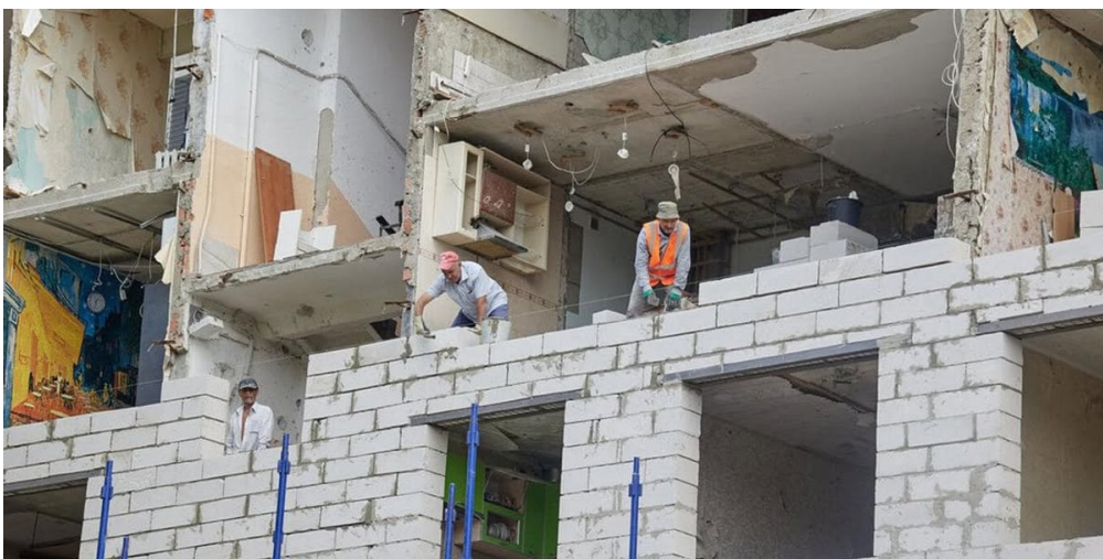
Ремонт багатоповерхівки в Харкові. Фото з фб-сторінки Харківської міської ради
