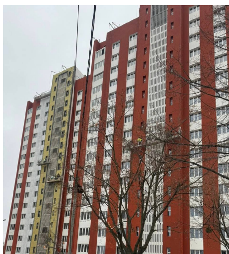
Фасад однієї з відновлених багатоповерхівок у Харкові. Фото з тг-каналу Харківської міської ради
