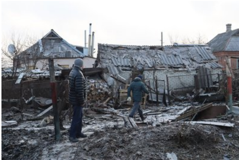
Пошкоджені будинки в Охтирці. Суспільне Суми
