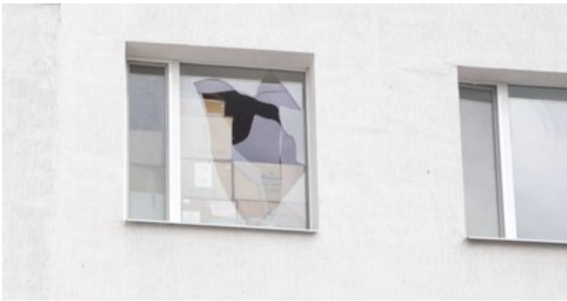
Глухівська лікарня після обстрілу 30 вересня 2024 р. Суспільне Суми
